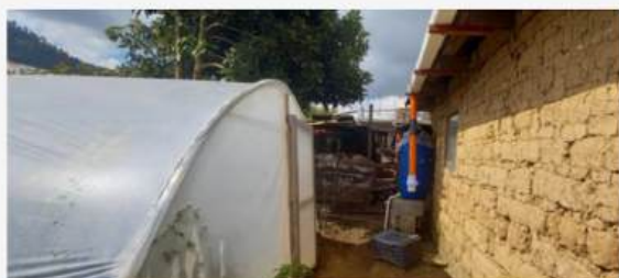
Sistema de captació d'aigua de pluja, Macro túnel, Xajaxac, Xipresals, Sololá
